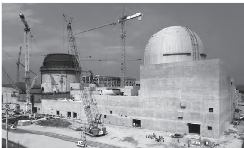
Les unités 3 et 4 de la centrale Shin-Kori, en construction.
