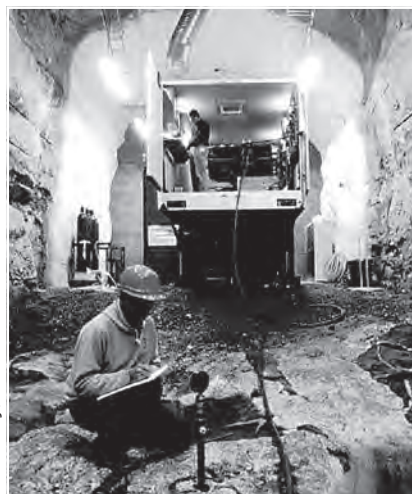
Vue du dépôt géologique en construction en Finlande.
