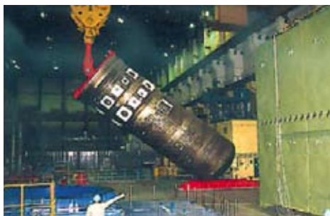
Rimozione del recipiente in pressione del reattore
