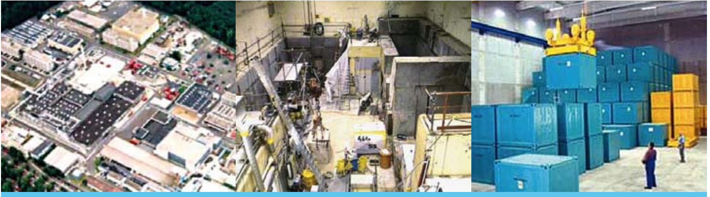
L'impianto prima del decommissioning
