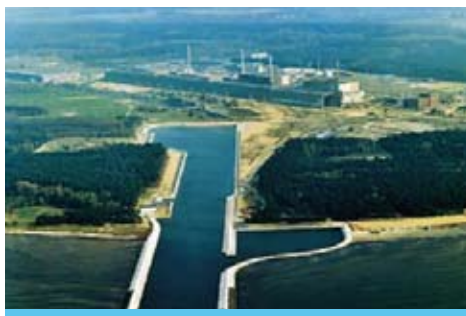
Veduta aerea dell'impianto
