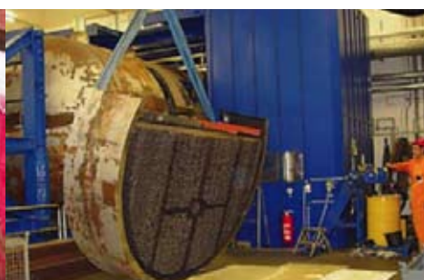
Taglio di un generatore di vapore con una grande sega a banda nell'Impianto Nord di Immagazzinamento Temporaneo (ZLN)
