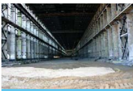
La sala turbine vuota
