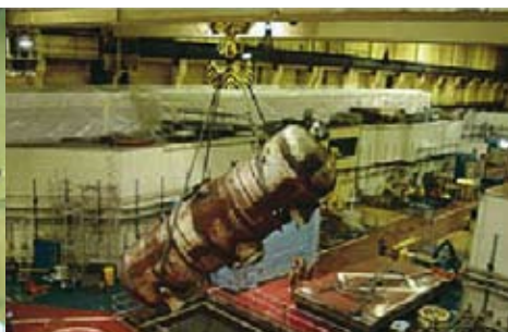
Smantellamento del generatore di vapore dell'Unità 4
