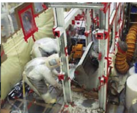
Nel corso dello smantellamento delle scatole a guanti.
