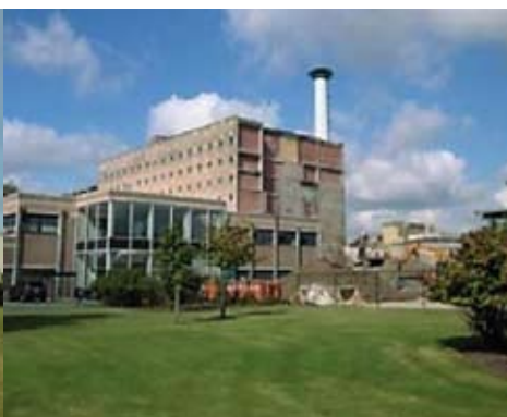
Durante la demolizione (agosto 2008)
