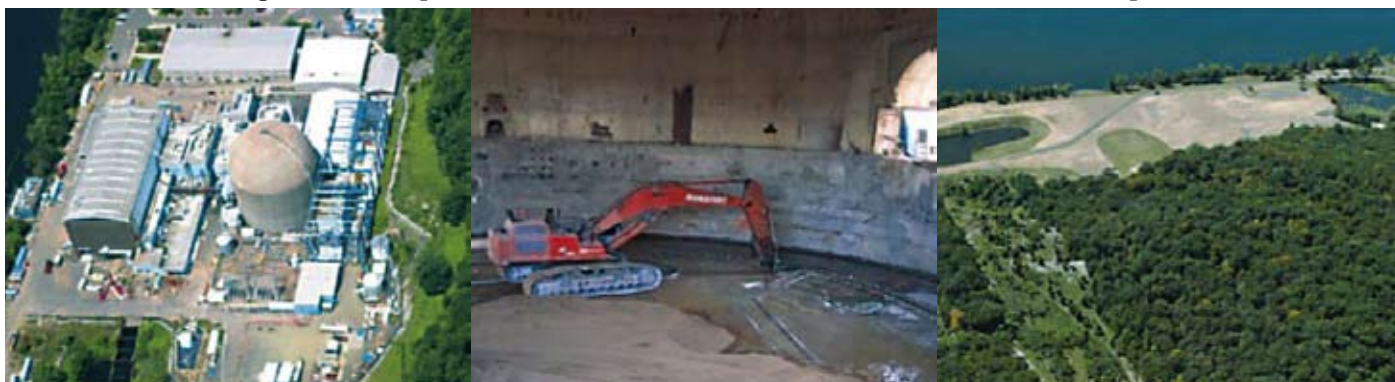
L'impianto prima del decommissioning
