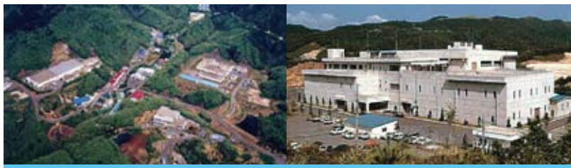
Centro di Ingegneria ambientale di Ningyo Toge. Impianto di raffinazione e conversione.
