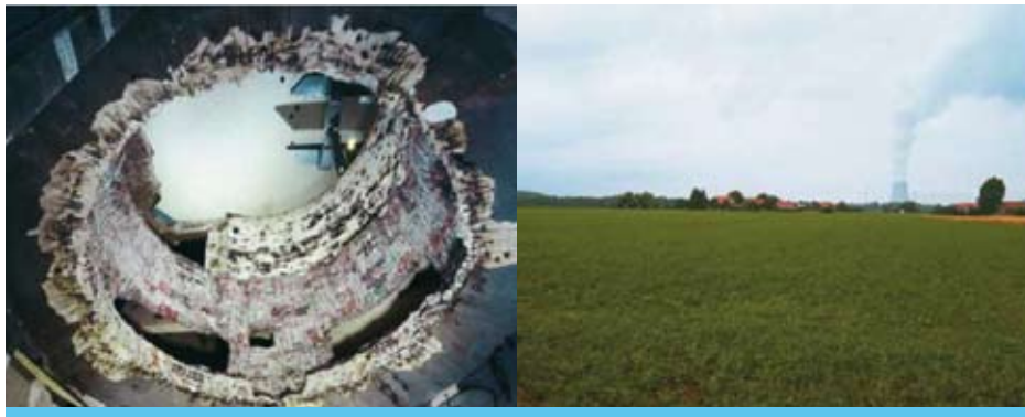
Smantellamento dello schermo biologico
