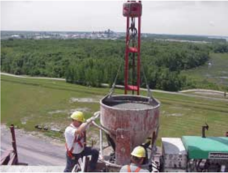
Figure 9: Deep Repair - Concrete Pour
